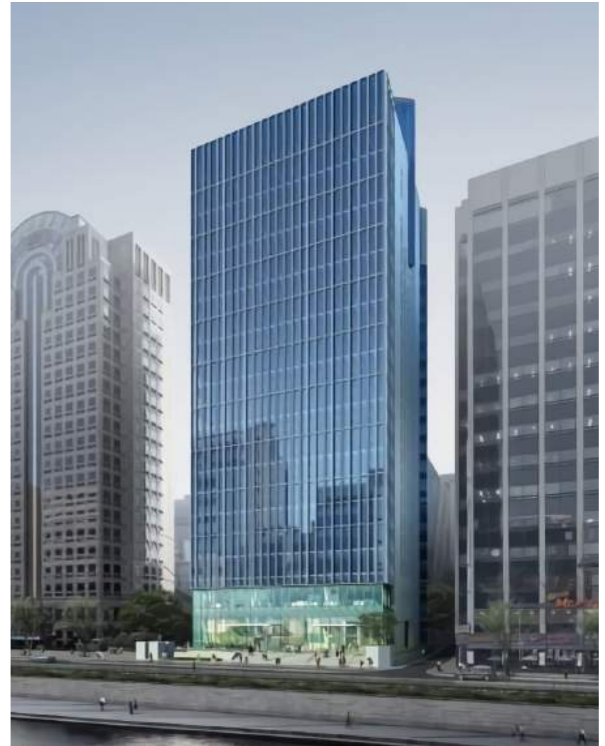
Ksquare City Remodeling 케이스퀘어시티 리모델링 공사
