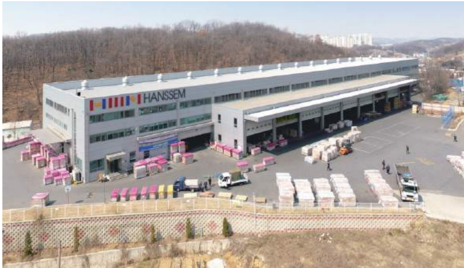
HANSSEM Manufacturing Facility 시흥 (주)한샘 제1공장 개축공사
