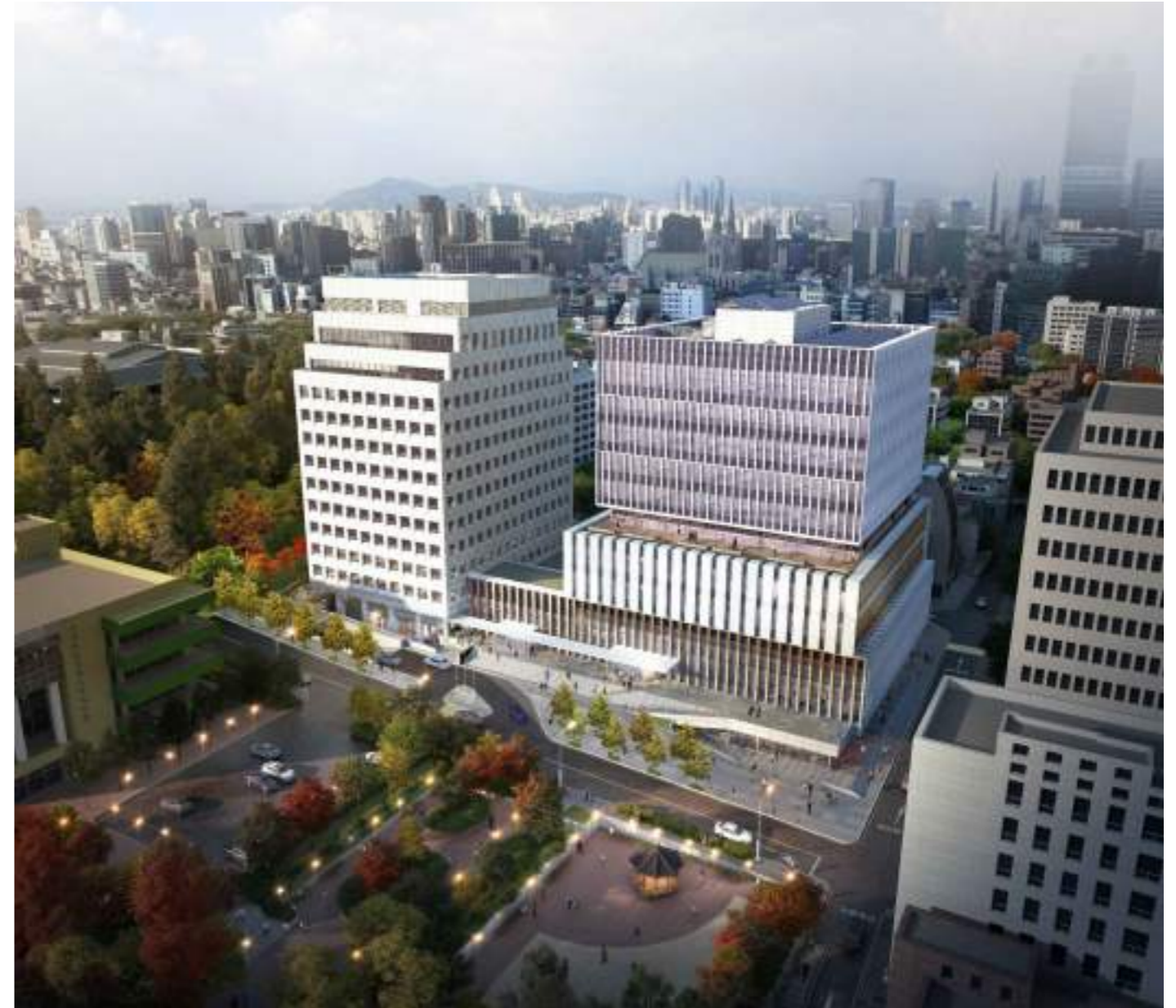
Science Plaza 과학기술인 복지콤플렉스 건립 건축공사
