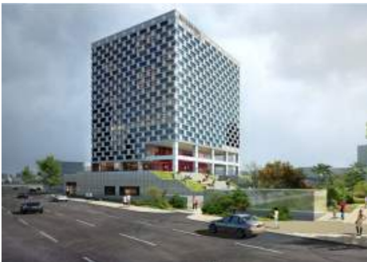
Pohang Jungang-dong Newdeal project bBase facility construction (Government Building, Culture factory)포 포항시 중앙동 도시재생뉴딜사업 거점시설 조성공사 (청사, 문화팩토리)
