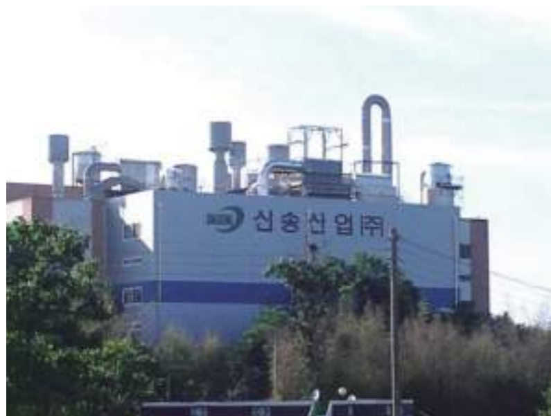
Sinsong Industrial Food Factory 논산 신송산업(주) 공장 증축공사
