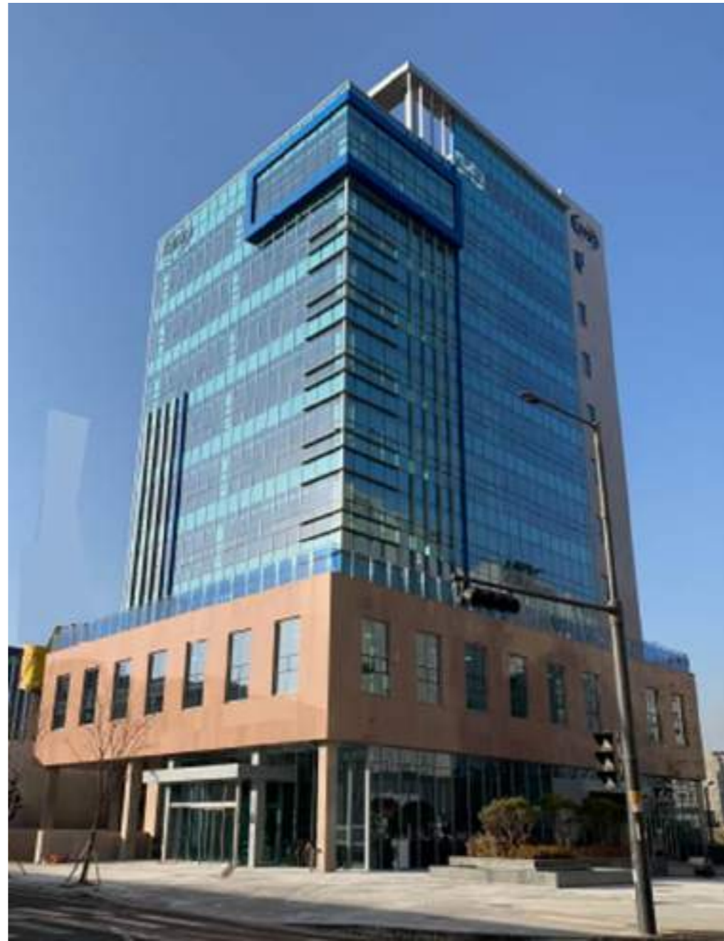
Seil Precision Machinery R&D Center 마곡 세일정기(주) 연구시설 신축공사
