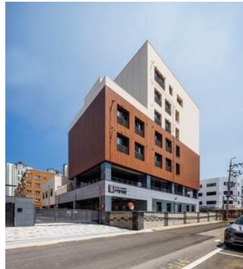
Amasa-dong Religious Facility 암사동 450-1 종교시설 신축공사
